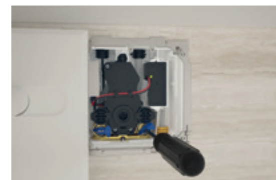
← Atskira techninė dėžutė įrengta lengvai pasiekiamoje vietoje po praustuovu – joje sudėti visi techniniai komponentai, išskyrus infraraudonųjų spindulių jutiklį. Tai yra ypač patogus atliekant techninę priežiūrą.
